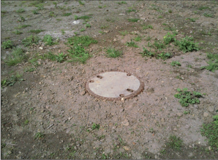
Revisionsöffnung über dem verfüllten Schacht „Carnall“ (Quelle: Archiv des Initiativkreises Bergbau und Kokereiwesen e.V.)
