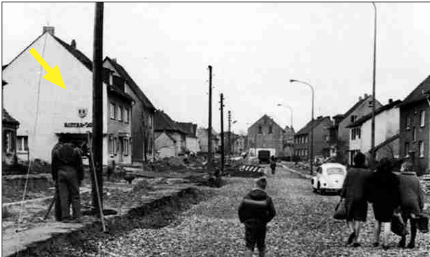
Ausbau der Oberheidstraße mit der „Mühlenbachklause“ (gelber Pfeil)
