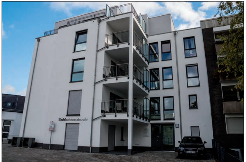
Neubau Wohnanlage Mellinghofer Straße 366 Mehrfamilienwohnhaus und Zahnarztpraxis Dr. Mersmann
