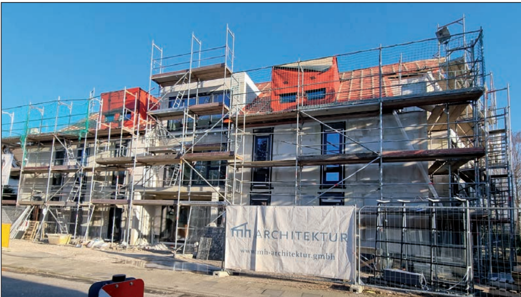
Rohbau am Wenderfeld 66
