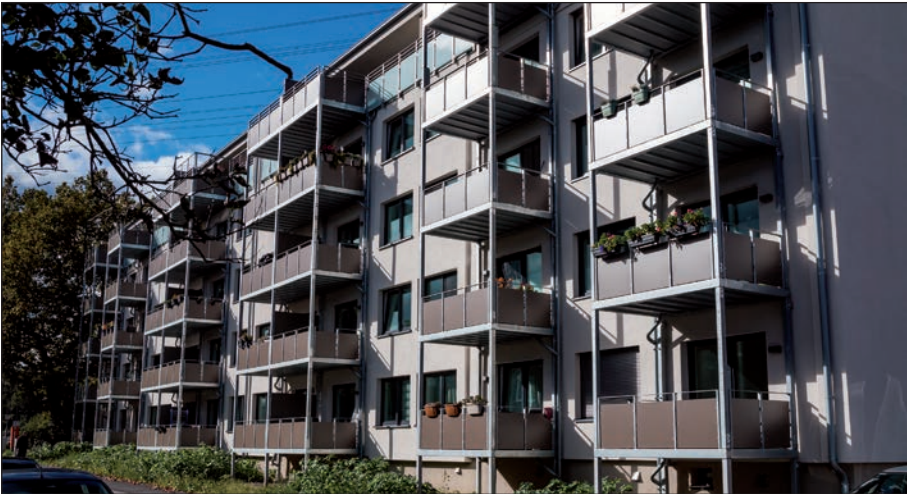
Das kernsanierte Stadthaus Magdalenenstraße 42 - 48
