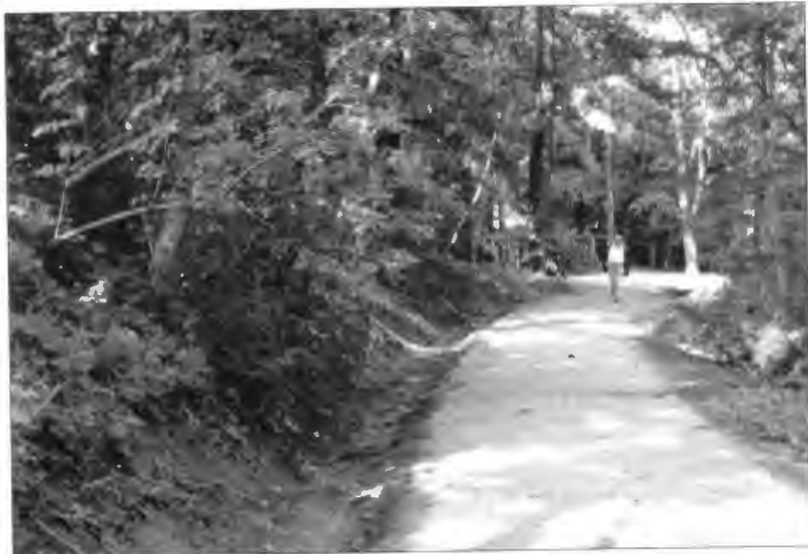
Nach langen Bauarbeiten (fast) wieder begehbar: Das Hexbachtal
