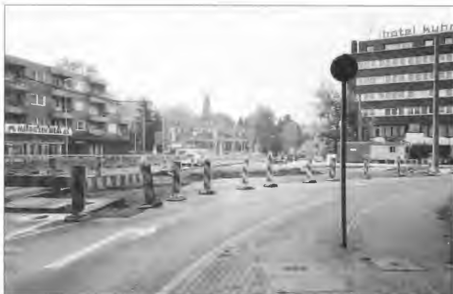
Die neue Einfahrt ins Gewerbegebiet oder auf die Umgehungsstraße ist schon zu erkennen
