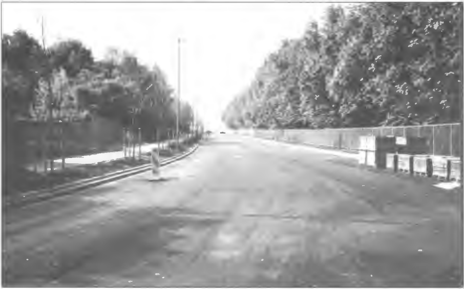
Zwischen Schulthenhofstr. und Fritz-Thyssen-Str. fehlt nur noch die Fahrbahndecke
