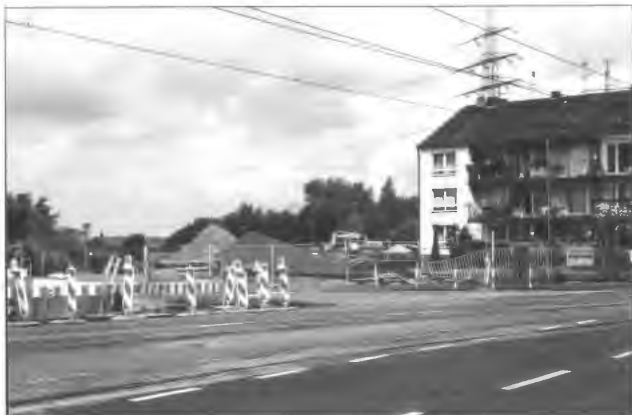
Hier entsteht die Kreuzung Mellinghofer Straße / Mannesmannallee (früher Tor 6)
