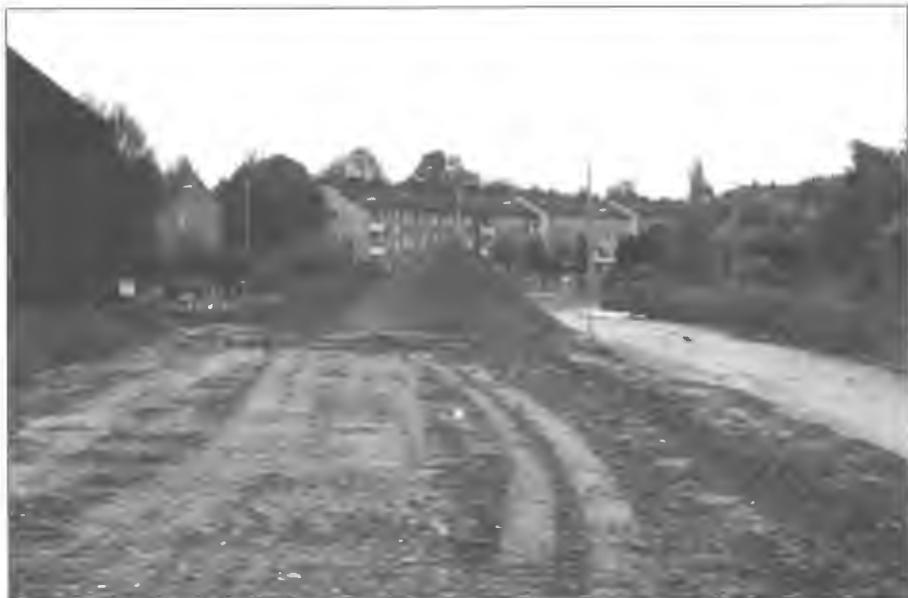
Großräumige Erdarbeiten im hinteren Bereich des Mannesmann-Parkplatzes
