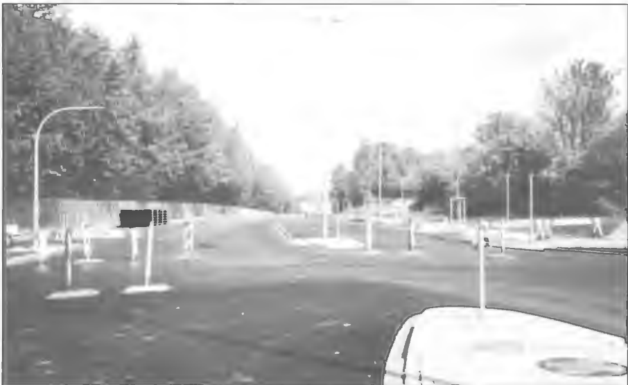
Auch der Kreuzungsbereich Fritz-Thyssen-Str./Mannesmannallee ist fast fertig ausgebaut
