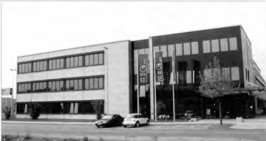
Das neue Verwaltungsgebäude der MEG mit anschl. Betriebshof an der Pilgerstraße
