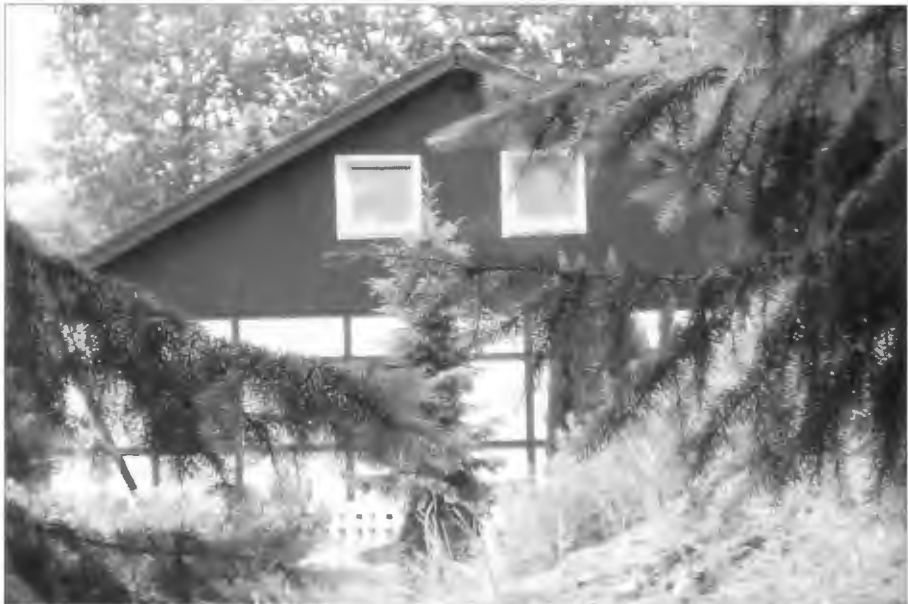
Das Fachwerkhaus hinter der Reithalle an der Oberheidstraße
