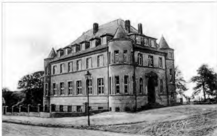
Das 1924 neu errichtete Gemeindehaus am Schildberg
