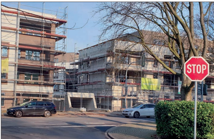
Einfahrt zur Tiefgarage
