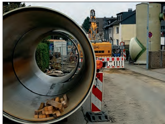
Das riesige Staukanal-Rohr
