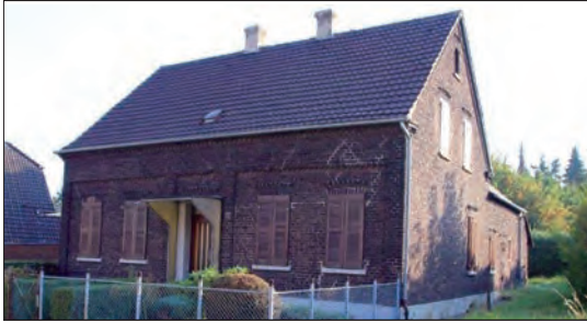
Das alte Zechenhaus
