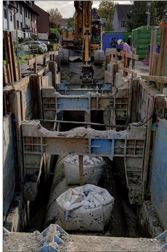
Die bis zu 7m tiefe Baugrube
