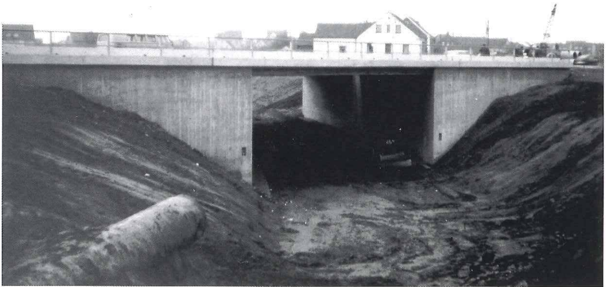
Bau der Unterführung unter die A 40 an der Mühlenstraße.
