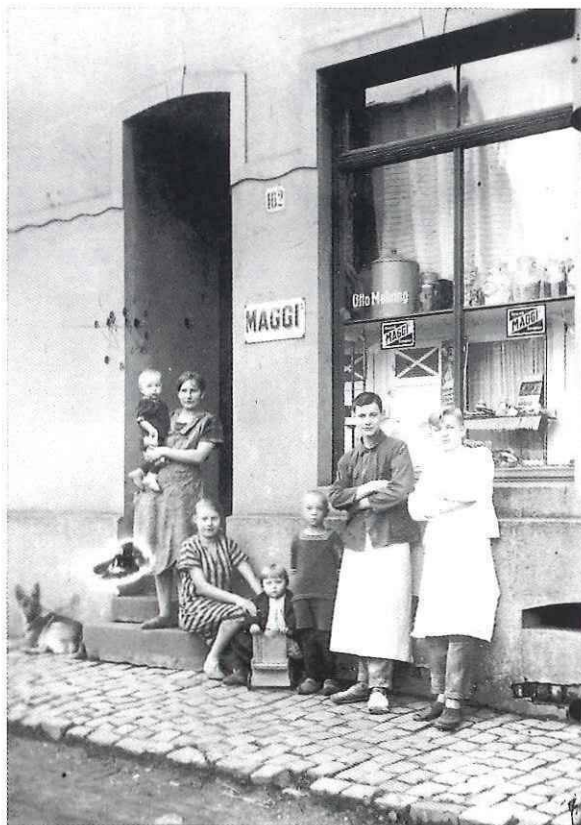
Bäckerei Mehning an der Denkhäuser Höfe. Früher endete hier die Linie 102
