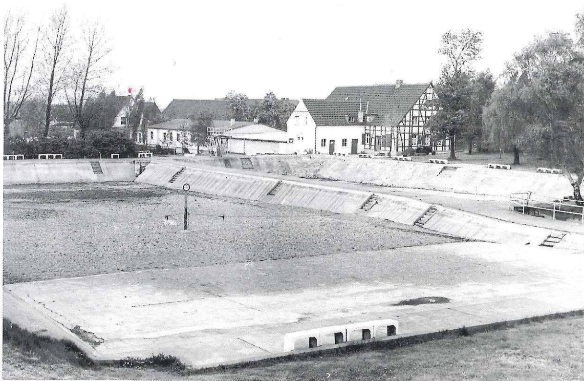
Schwimmbad Kämpgens Hof.
